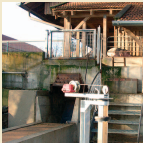
Vom Schweinestall direkt in die Biogasanlage
